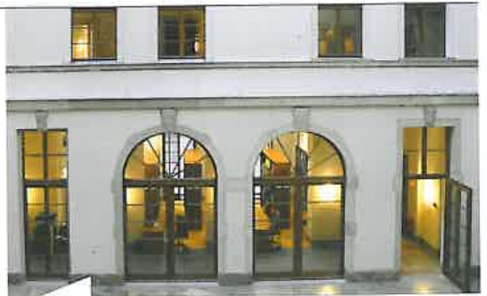
Fensterelemente für das Bundesumweltministerium.
